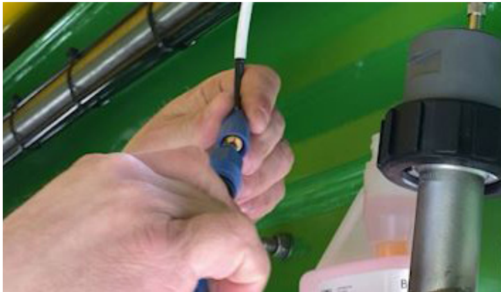
Abb. 91. Kabel mit Sensor verschrauben
